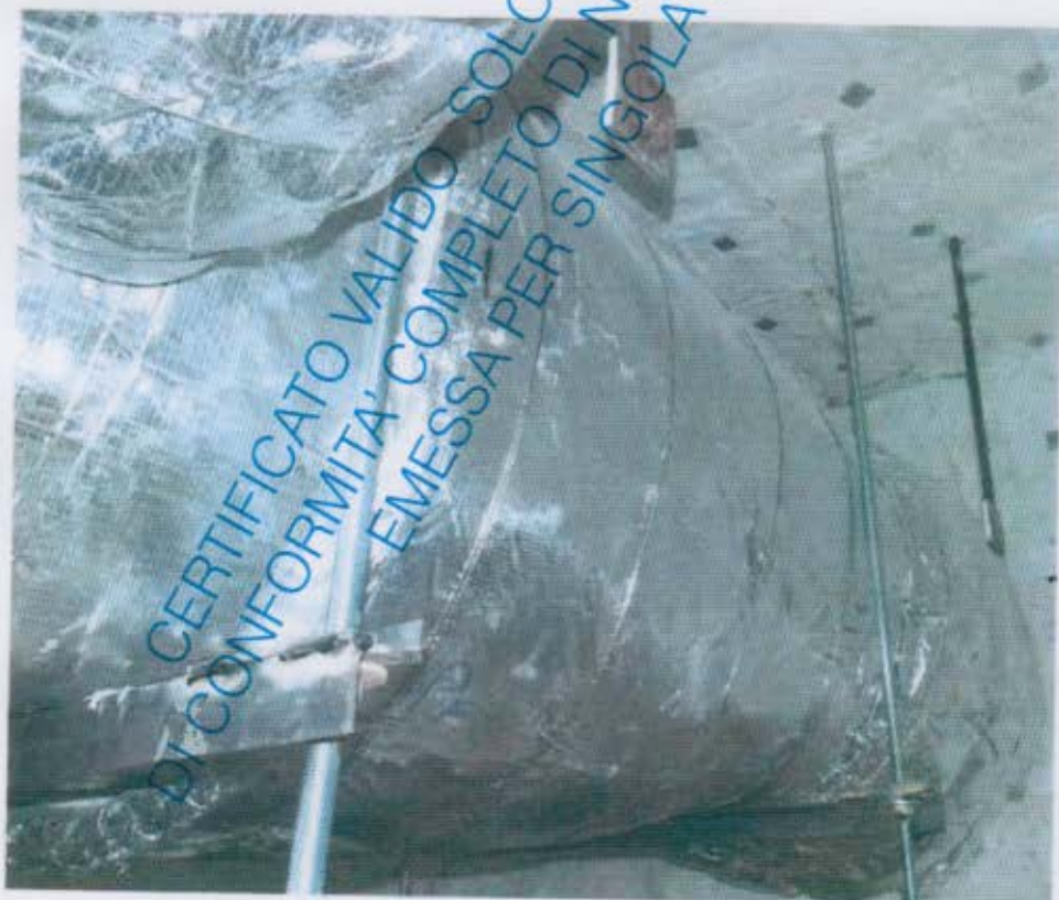
Foto.5/6 - Vincolo e isolamento del tappo di fondo
