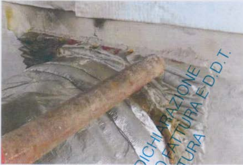
Foto.12 - Dettaglio dell'attraversamento a parete, dopo la prova
