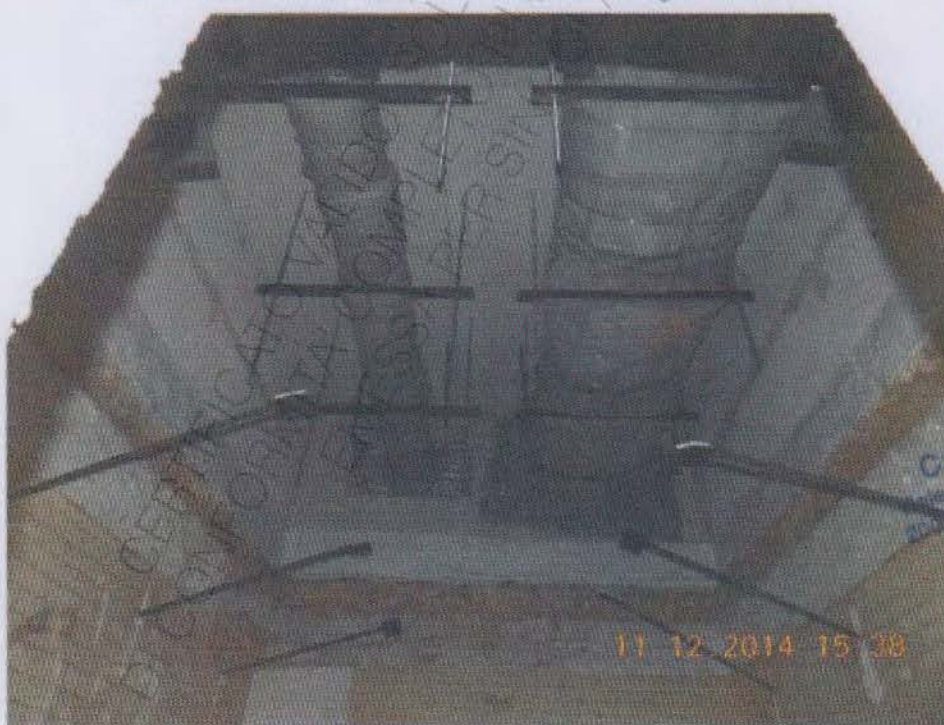
Foto 8. prima della prova - Dettaglio interno camera d'incendio
