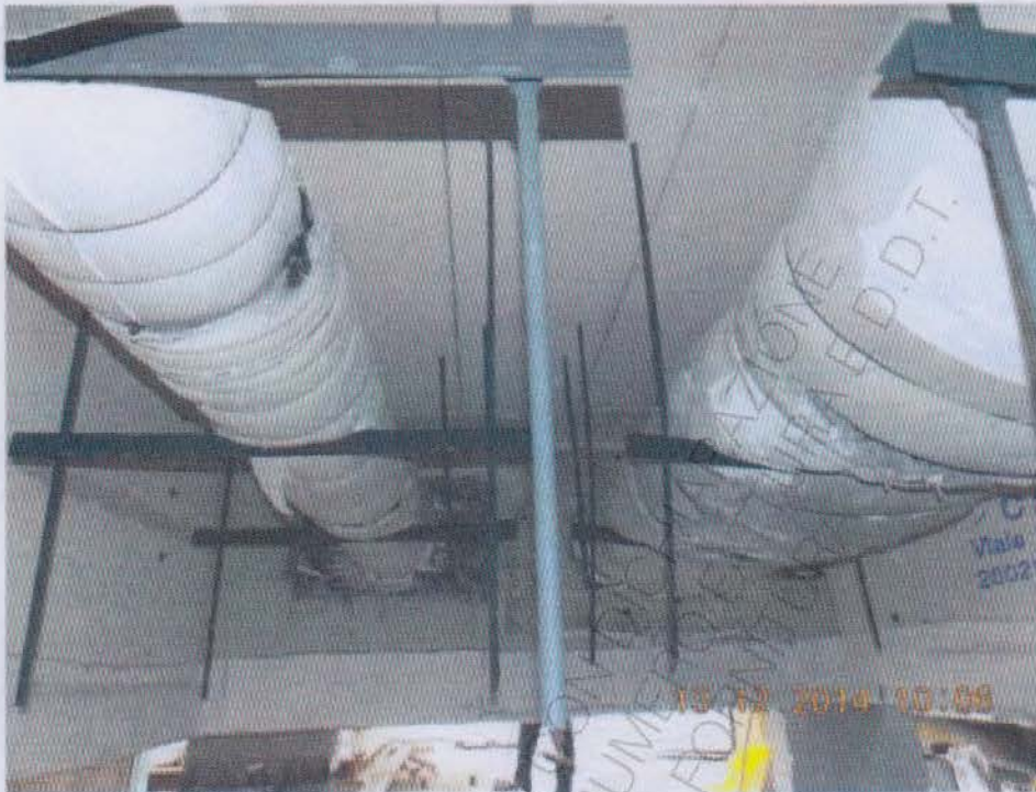
Foto 11. Campioni dopo la prova - Dettaglio interno camera d'incendio
