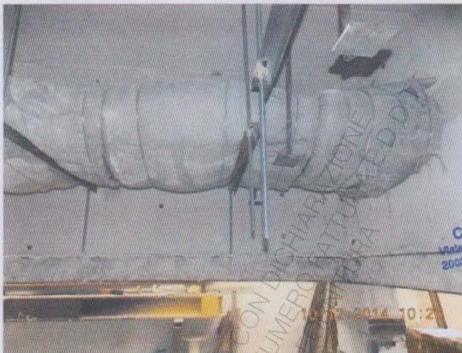
Foto 7. Canalina 600x80 mm prima della prova - Dettaglio chiusura in testa
